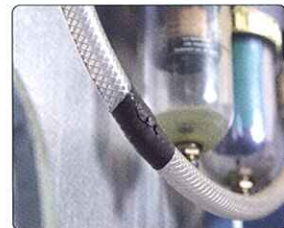
Abdichten eines Druckluftschlauches
