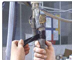
Abdichten eines Lackierschlauches
