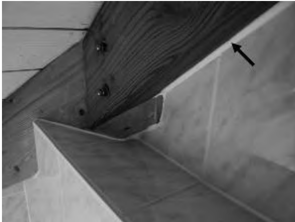
Bild 11: Abdichtung von Deckenbalkenkonstruktion gegen Fliesenbelag
