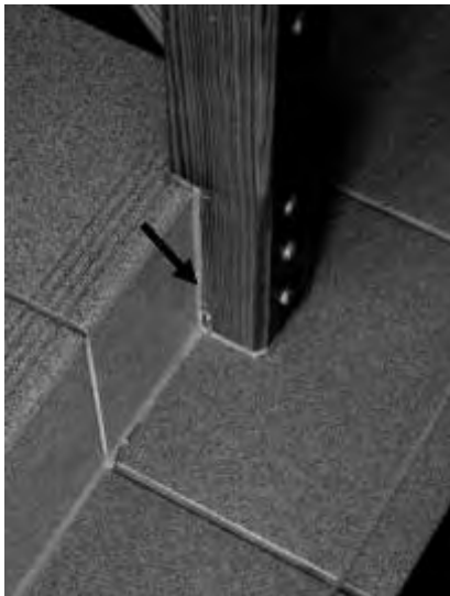
Bild 12: Abdichtung zwischen Treppenfuß und Bodenbelag
