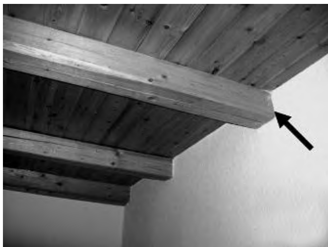
Bild 10 Deckenbalkendurchführung in die Wand
