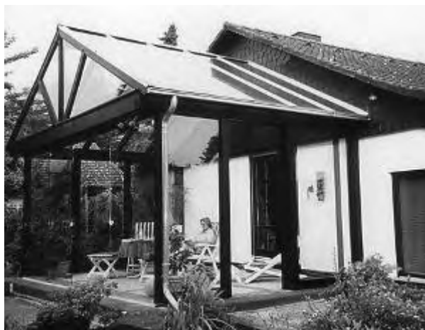
Bild 6: Wintergarten, Anschluss der Holzbalken zum geputzten Baukörper
