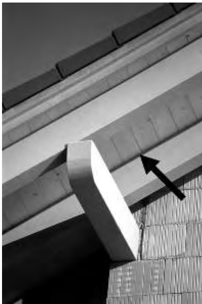
Bild 7: Dachuntersichten - Abdichtung des überstehenden Schrägdachs zum Tragebalken
