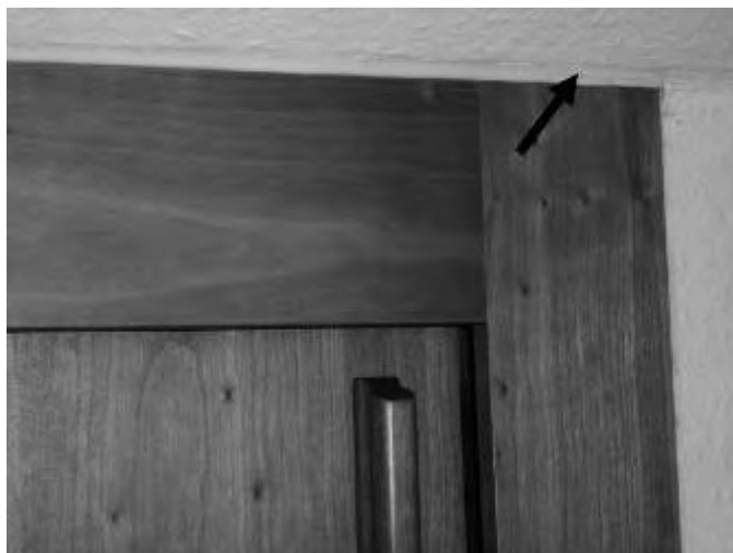
Bild 9 Einbauschränk, Abdichtung gegen Dachschräge
