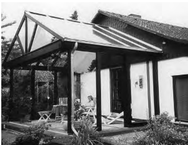
Bild 6: Wintergarten, Anschluss der Holzbalken zum geputzten Baukörper
