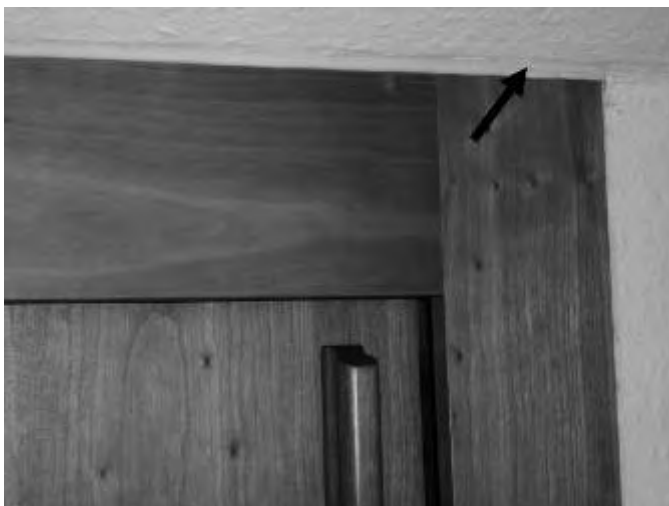
Bild 9 Einbauschränk, Abdichtung gegen Dachschräge
