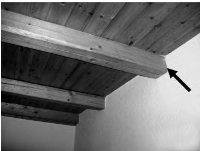
Bild 10 Deckenbalkendurchführung in die Wand
