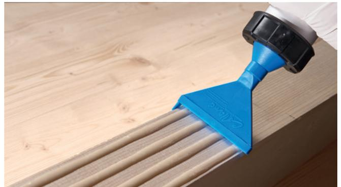
Der dosierte und optimal positionierte Klebstoffauftrag garantiert eine sichere Verbindung.
